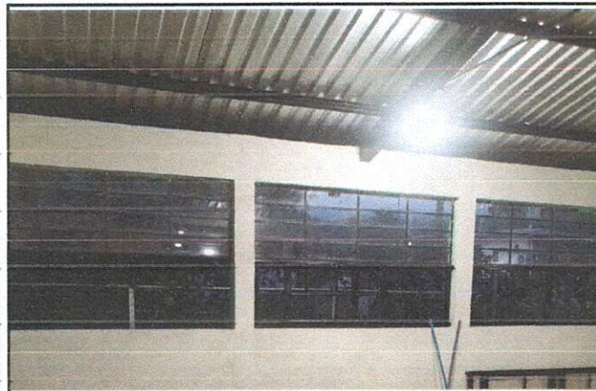
Foto 3: Avance del mejoramiento de ventanas
