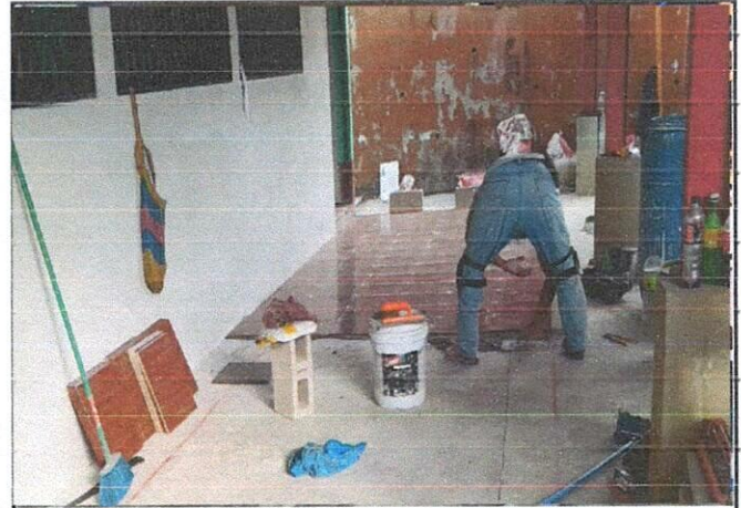
Foto 2: Avance del mejoramiento del piso
