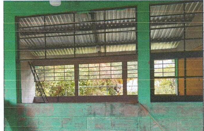
Foto 4: Avance del mejoramiento de ventanas
