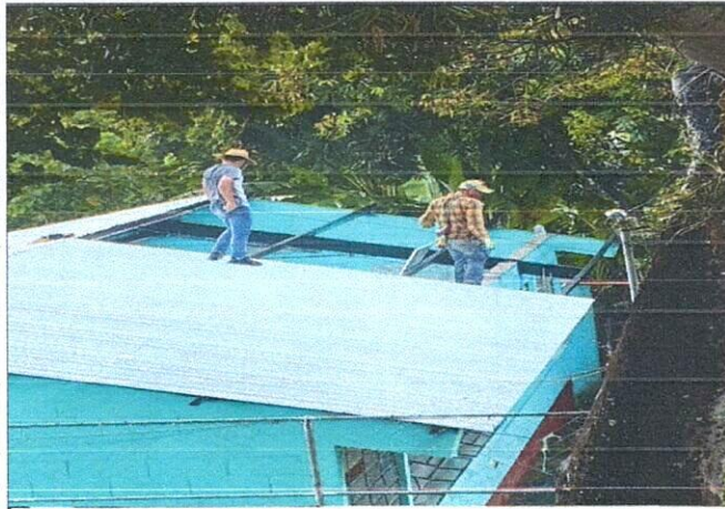
Foto1: Avance en el mejoramiento de la cubierta de lámina
